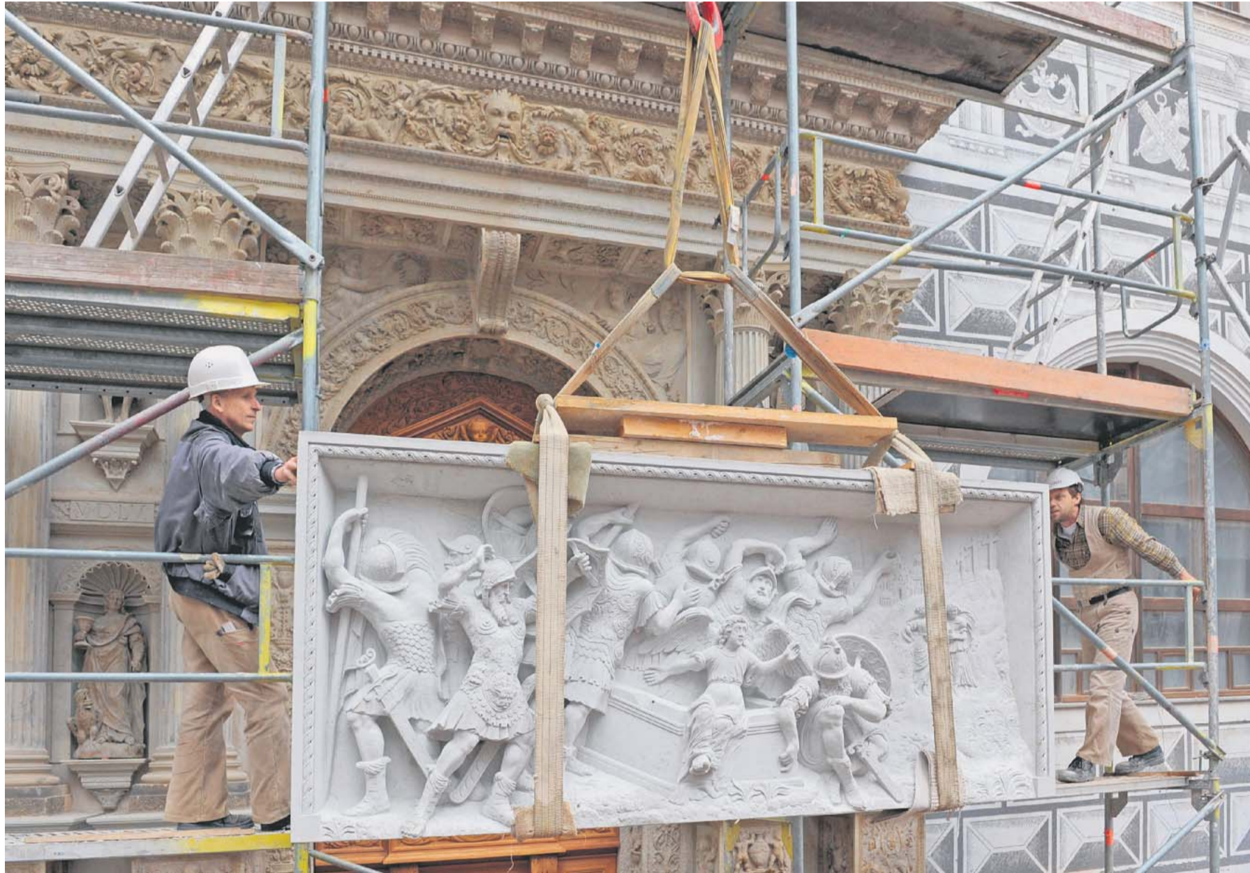
Krönender Abschluss: Steinmetze dirigieren im Dresdner Schlosshof das Relief „Auferstehung Christi“ auf das Renaissance-Portal des Residenzschlosses.
